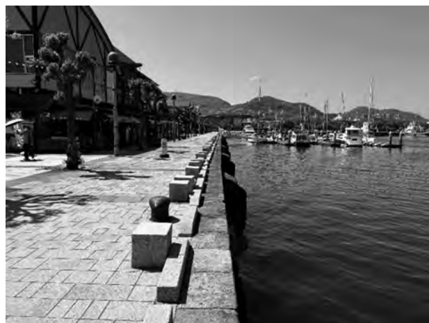
写真-1 現在の出島岸壁
