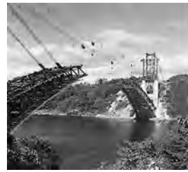
写真-2 架設状況
