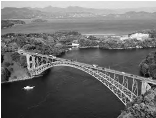
写真-1 70歳になった「西海橋」
