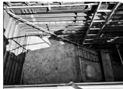
写真-4公開された基礎部(掘削部は鋼矢板で土工)
