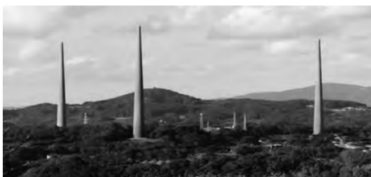
写真-1無線塔の3本柱(西海橋公園側から撮影)
