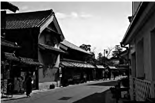
旧東海道筋「有松」の町並みと連なる歴史的建造物
