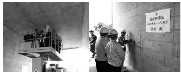
写真-3 高所作業車
