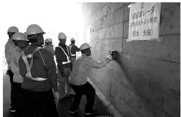
写真-5 電磁波レーダ操作状況（生徒による）
