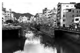
写真-2 バイパス水路下流部
