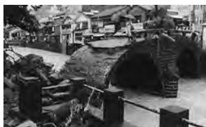
写真-1 被災した眼鏡橋
