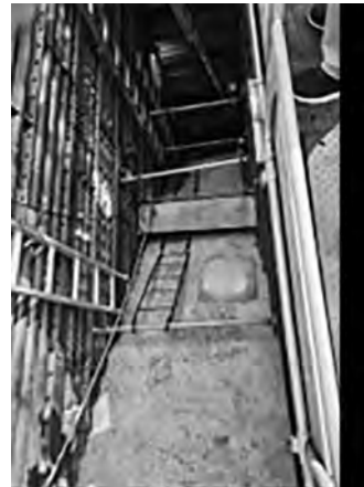
写真-3 公開された基礎部 (掘削部は鋼矢板で土留)
