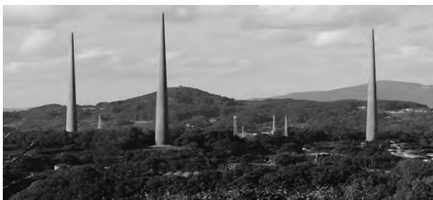
写真-1 天にそびえる針尾無線塔の3本柱
