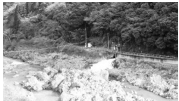
堅磐部に構築された余水吐、山裾を削り下流へ
