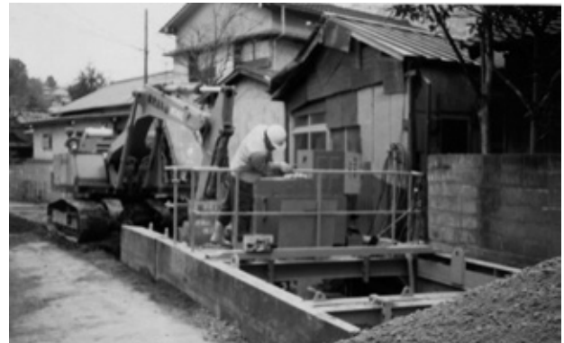
写真-1 オープンシールド機による掘削
