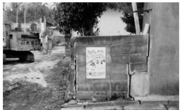
写真-2 水位低下による地表変状
