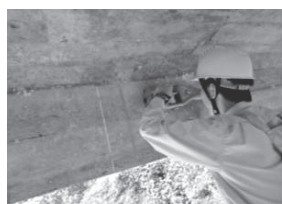
写真-2 鉄筋探査状況 (電磁波レーダー)
