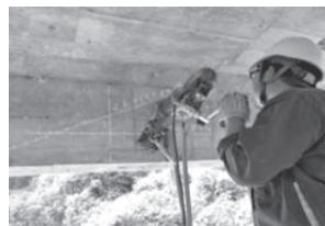
写真-3・4 コア採取状況・コア供試体
