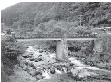
写真-1 おかくら橋全景
