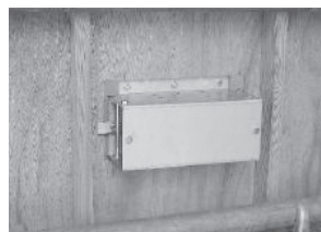
写真-4 ボス型枠取付け
