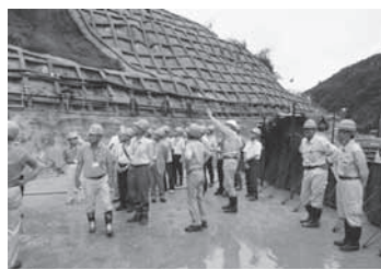
五ヶ山ダム堤体上での林所長(建設JV)による説明 (写真②)
