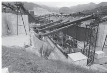
五ヶ山ダム骨材製造工事プラント (写真③)
