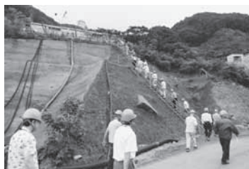
五ヶ山ダムコンクリート打設現場へ向かう仮設階段 (写真①)
