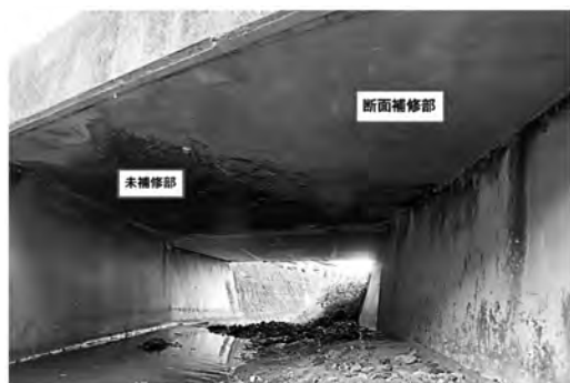
写真-1 橋梁（補修）状況
