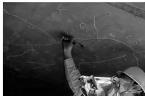
写真-4 弾性波の入力状況（インパクト）
