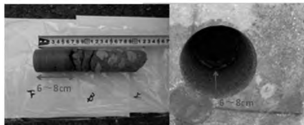
写真-6 測定点D-5のコアとコア内部
