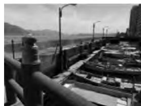
写真-5 系船岸式防波堤
