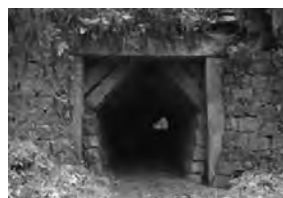
写真3 石組み隧道
