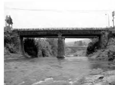
写真-2 現在の明治橋の状況
