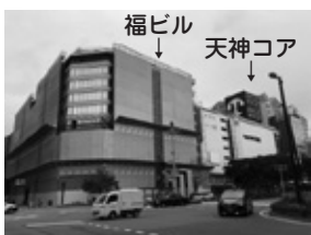
福ビル解体へ(2020.4)
