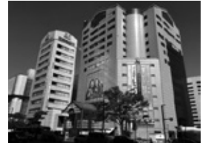
イムズ(右側建物)解体予定
