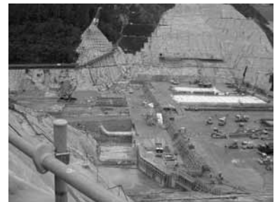
嘉瀬川ダム工事
