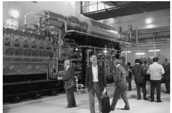
ガス・重油どちらも稼働の発電器
