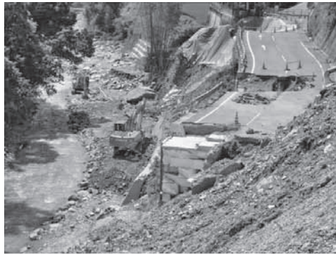
写真-1 災害復旧現場（県道後川内黒木線）
