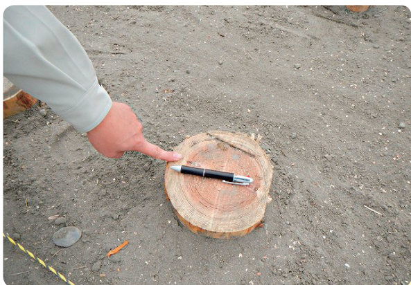
打ち込み完了
