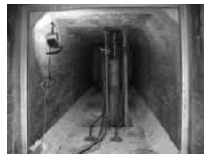
写真－1 鉛直載荷試験状況
