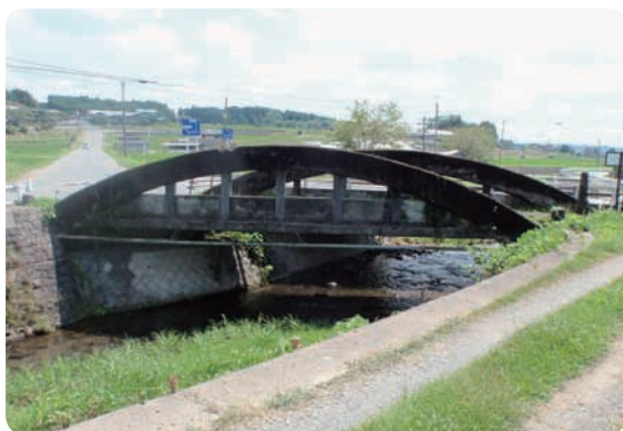
姫井橋 (土木学会選奨土木遺産)
