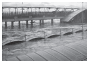
被災時の仙台空港 約3m浸水
