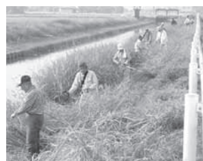
(写真↑ 共同作業による水路法面の草刈り状況)
