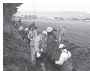
(写真↑ 共同作業による水路泥土上げ状況)
