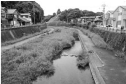
写真-1 丘陵地を開削して付け替えられた現在の板櫃川
