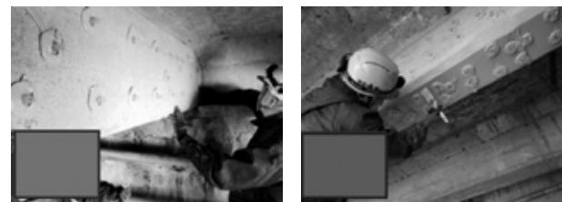
写真-4 台座取付および漏れ止め状況
