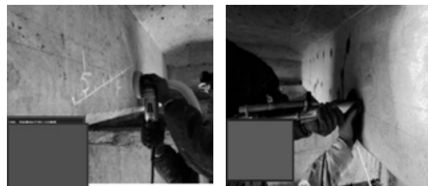
写真-3 表面研磨および削孔状況
