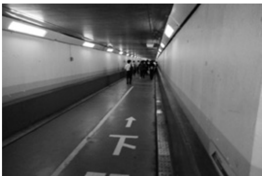
現地見学会(関門トンネル人道)
