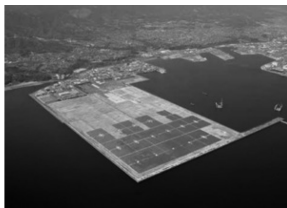
写真1 七ツ島の太陽光発電システム 6)
