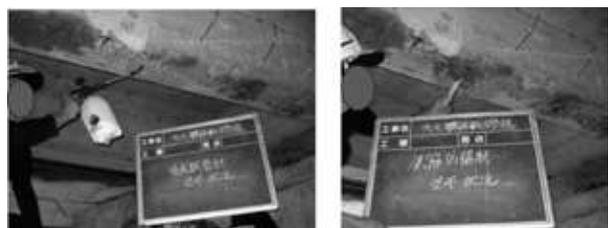
写真-5 吸水調整材および鉄筋防錆
