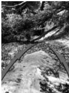
隣接流域の洪水で流末水路が壊れた例
