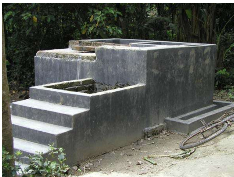
図-4.3(2) 浄水設備外観（工事中止）
