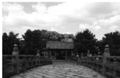
写真-2 溶結凝灰岩からなる橋上部と西田橋関 五石橋の石材には火砕流堆積物である溶結凝灰岩
