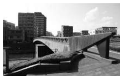
写真-4 新西田橋
