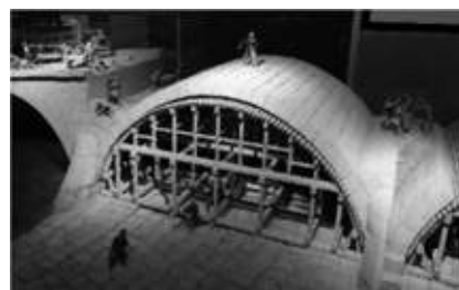
写真-3 石橋築造方法の解説模型（石橋記念館）
