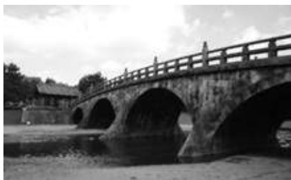
写真-1 移設復元された西田橋
