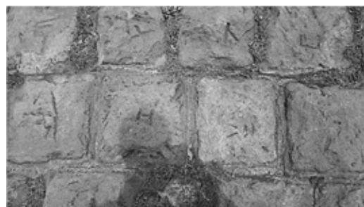
石積防波堤の巻石接写
