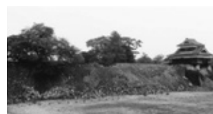
写真5 本震で石垣が全面崩壊
