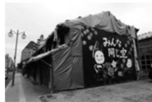
写真3 写真2の建物は現在修復中
