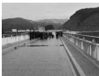
(写真1) 五ヶ山ダム 完成した堤体
