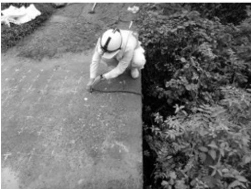
写真-5 上面受信センサー設置状況
