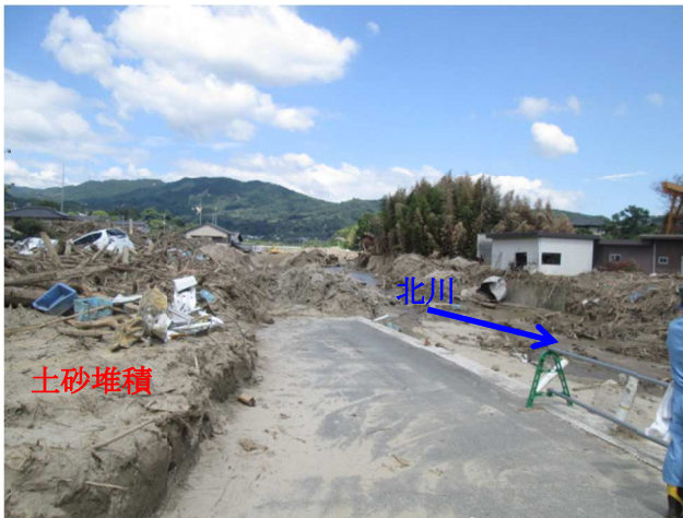
写真 22 災害後の北川氾濫状況
