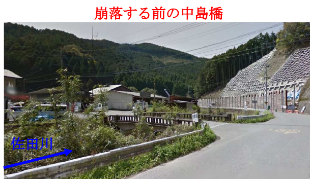
写真7 崩落前の中島橋（※グーグルマップより引用）
