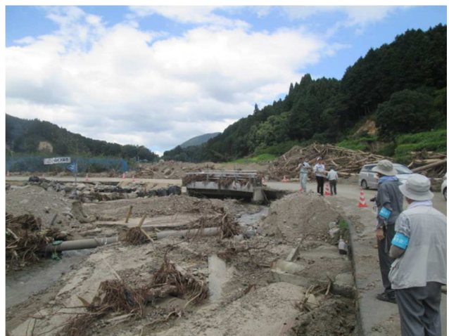
写真15 災害後の赤谷川
