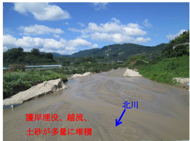
写真 27 災害後の北川氾濫状況
