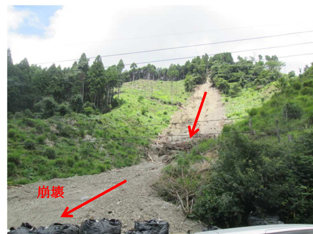
写真9 佐田川上流部の大規模斜面崩壊状況
