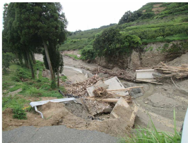
写真 37 ため池決壊後の下流状況
