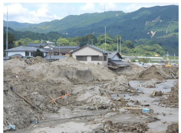
土砂・流木で被災・孤立化した集落災害（北川沿い）
