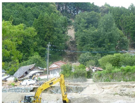
県道 52 号線沿いの被災状況 (家屋裏山からの土砂崩れによる家屋被害)
