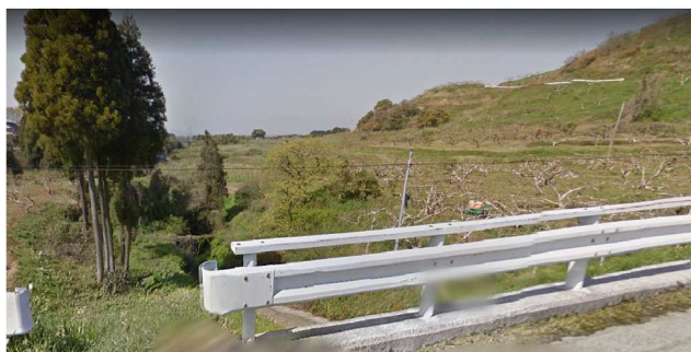
写真 36 ため池決壊前の下流状況（グーグルマップより）
