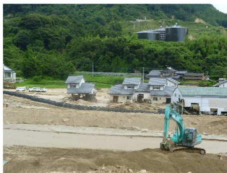
赤谷川沿いの被災状況 (土石流による家屋の流出状況)
