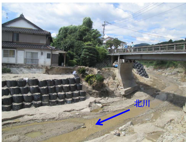
写真 30 災害後の北川被災状況
