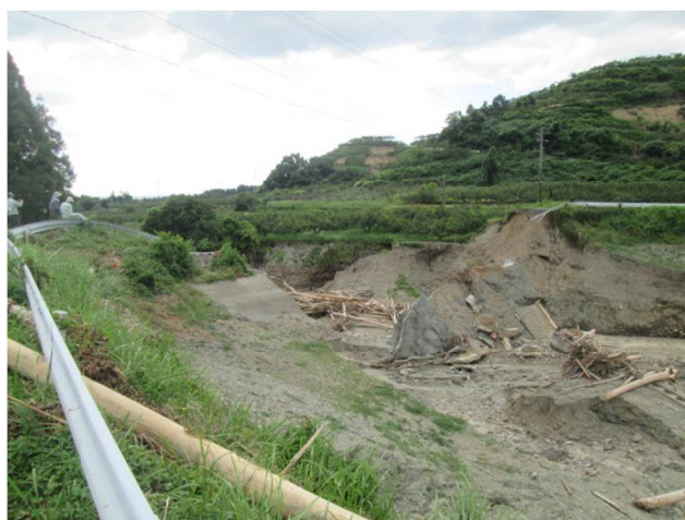
写真 35 ため池決壊後の状況
