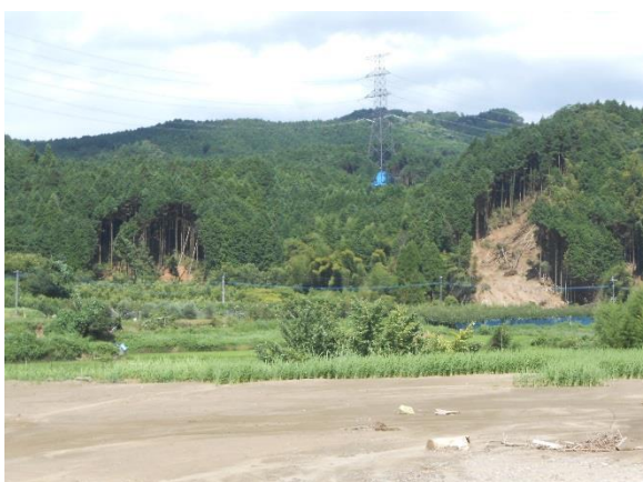
後背遠景の破壊（黒川地区）
