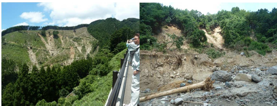
写真 1.2 流域上流部山腹崩壊、斜面崩壊の状況
