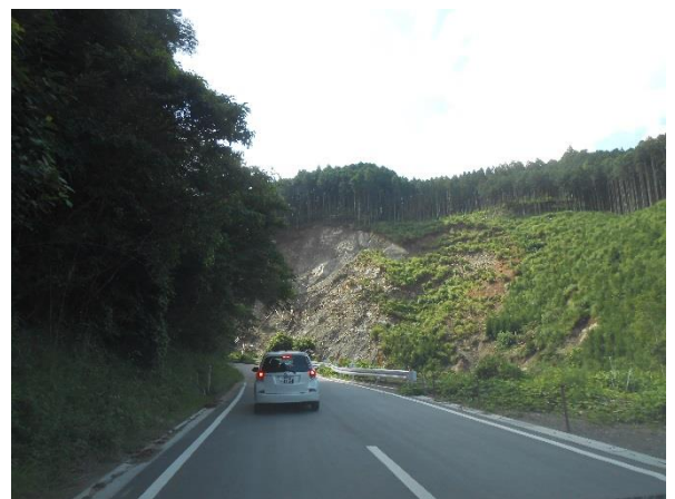
山間沿道景観の破壊（黒川沿い）
