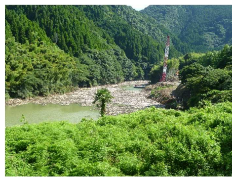
クレーンによる流木の撤去状況 (寺内ダム周辺)
