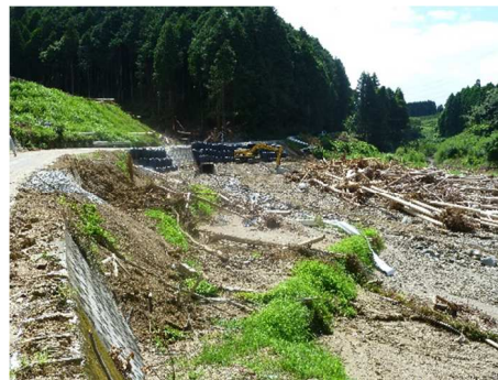
村道の仮復旧中工事の状況 (盛土斜面の仮復旧工事中)
