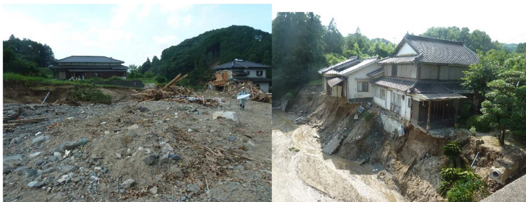
写真 7.8 上流部の河道および道路・果樹畑の流出状況
