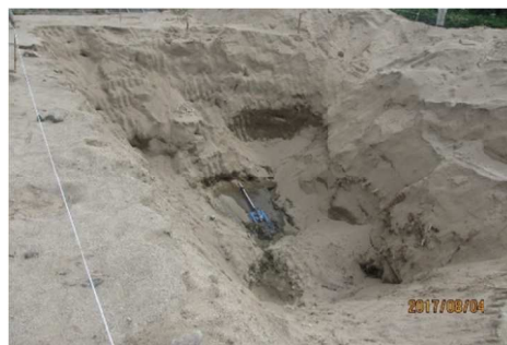
底樋、斜樋の状況(仮掘削している)
