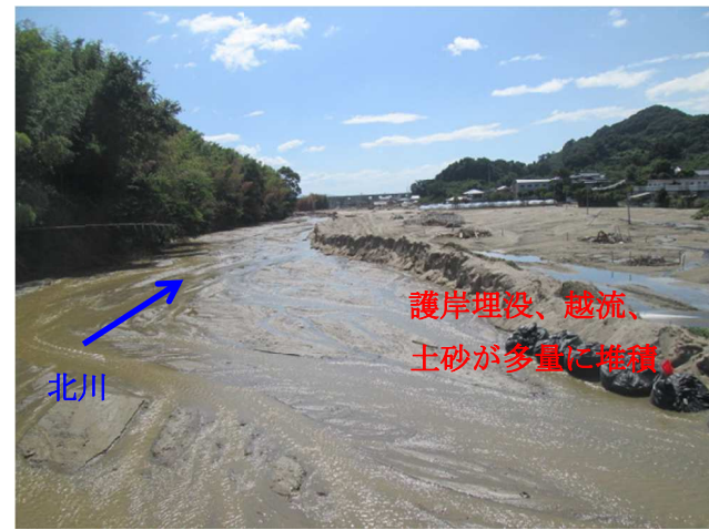
写真 25 災害後の北川氾濫状況
