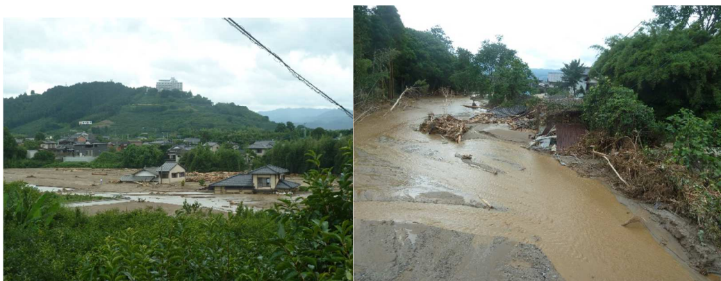
写真 11. 12 下流部の氾濫による土砂堆積（埋塞）状況
