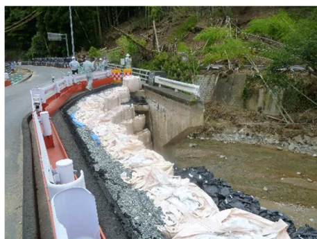
国道 211 号仮復旧工事 (橋台背面) (TEC-FORCE による道路啓開状況)
