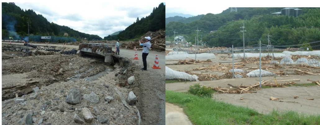
写真 9. 10 上流部の河道埋塞と中流部の氾濫状況
