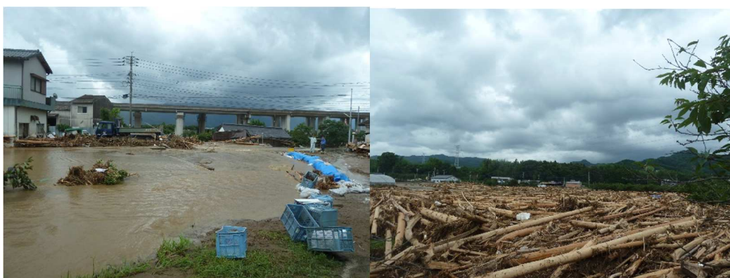
写真 13. 14 下流部の氾濫状況と流木堆積状況
