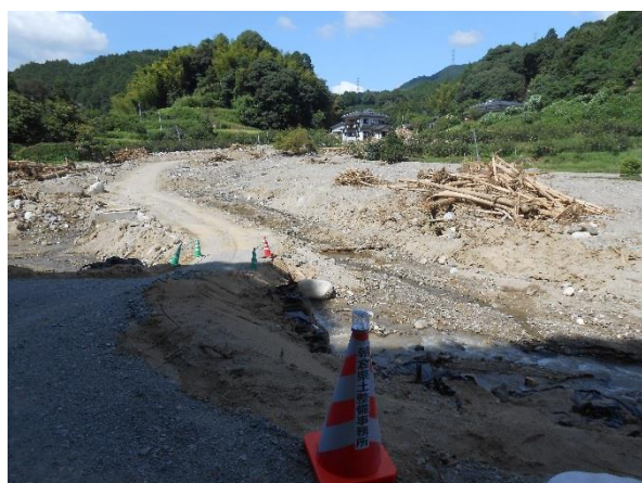
応急的に孤立化を解消した集落（北川沿い）
