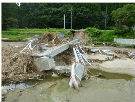
橋梁流出状況 (路線名は不明) (県道 588 号から校舎跡を結ぶ橋梁)
