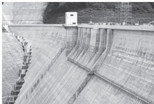
五ヶ山ダム堤体工事の状況
