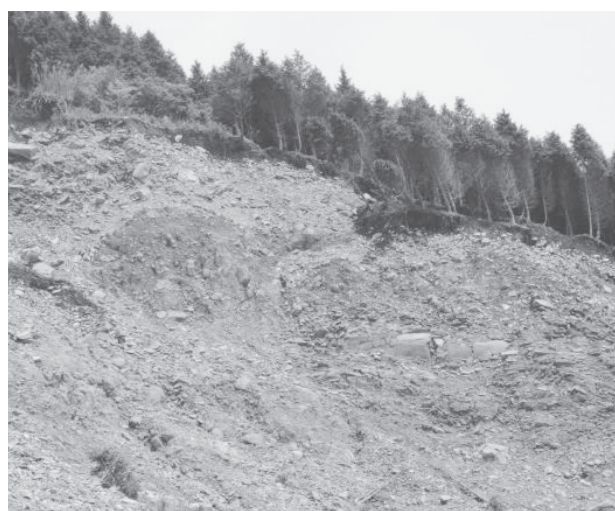
写真2 岩盤のクリープ変形
