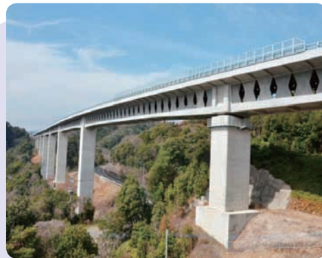
寺迫ちようちょ大橋 (宮崎県日向市)
