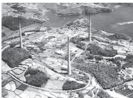
針尾無線塔全景
