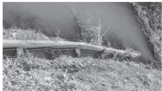
写真④ コンクリート製水田魚道(堰頂を研磨)
