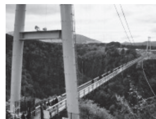
九重夢吊大橋 提供元：九重夢大吊橋管理センター
